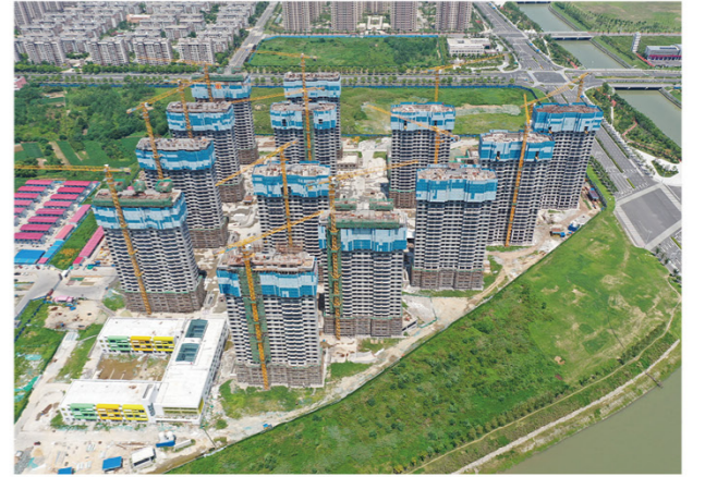
淮安高铁商务区文萃苑小区项目顺利封顶
