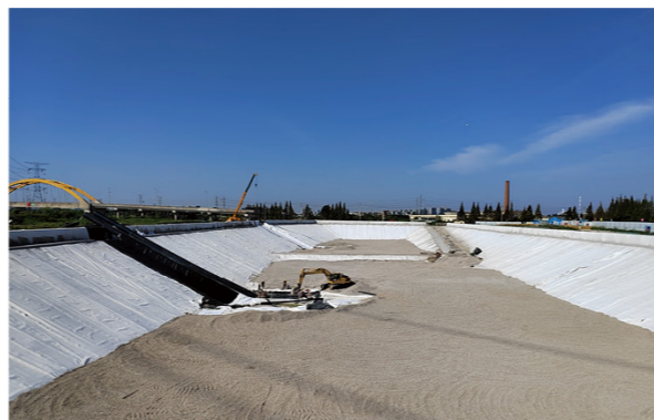
好基础。中亿丰基础设施将继续严格落实安全责任、坚持高标准严要求，确保项目顺利交付，助力生态环保事业。（中亿丰建设集团基础设施 高仕梅）
