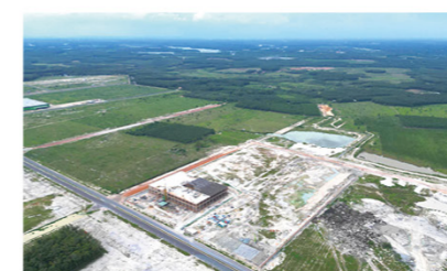
越南平福凯迪国际新建厂房项目
