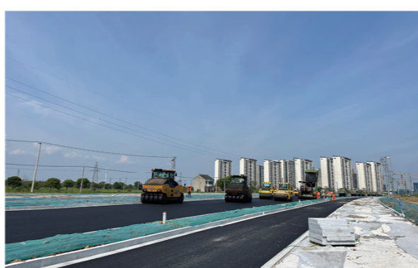
进行安全和技术交底，全面把控工程施工安全质量，确保一次成优。
