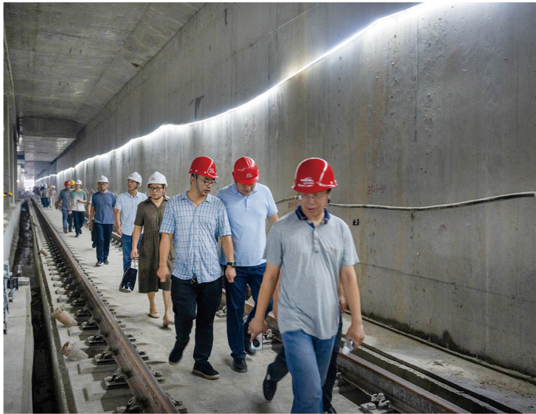
此次研究成果的圆满示范应用中亿丰即迈入联络通道施工的广大市场提供了重要支持，中亿丰将继续顺势而为，在城市轨道交通领域积极作为，勇于担当，为江苏省轨交事业做出应有贡献。（中亿丰建设集团基础设施 华俊凯）
