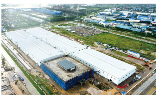
越南海防巨星智能新建厂房项目
