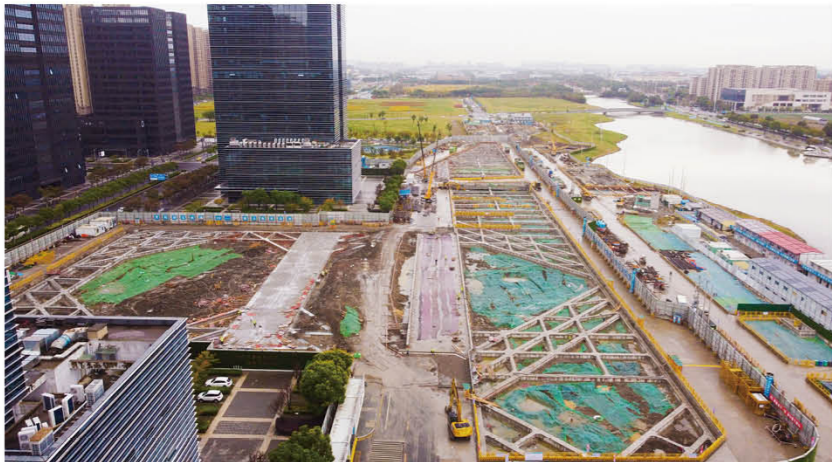
苏州轨道交通市域1号线金融街地下空间项目
