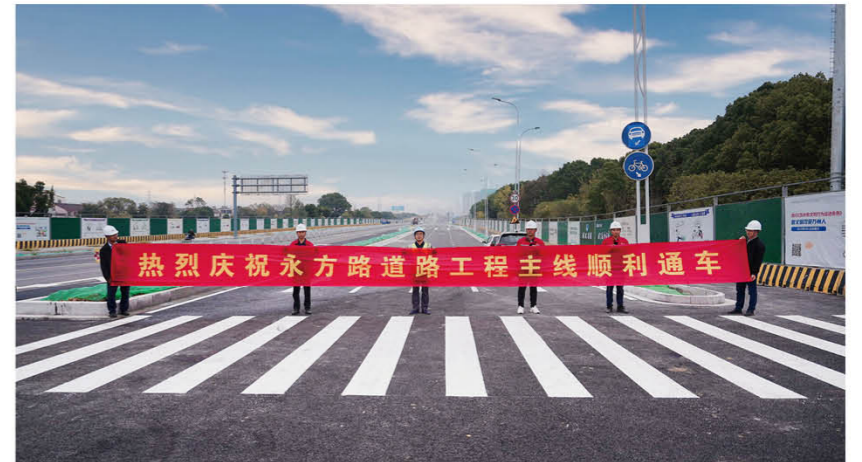
永方路（城北西路~阳澄湖西路）道路工程二标段主线顺利通车
