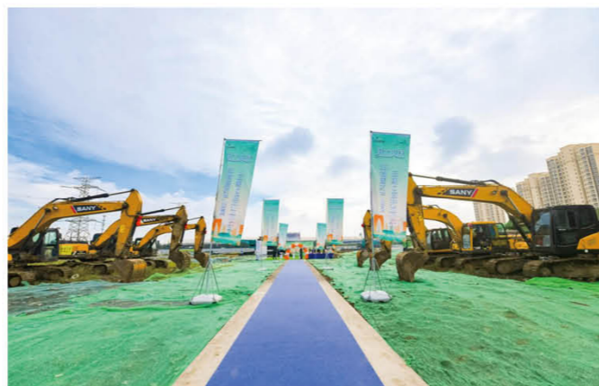
苏州生物医药产业园三期C区项目开工仪式
