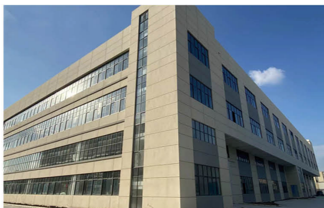
江苏万华通信厂房项目顺利通过竣工验收
