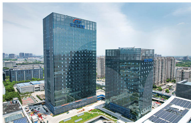
中亿丰未来建筑研发中心总部办公楼幕墙封顶
