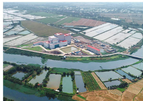
越南北海海创垃圾发电厂项目
