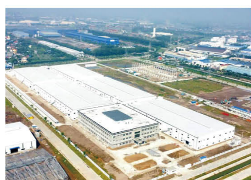
越南海防巨星智能新建厂房项目
