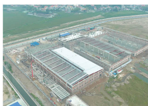
越南河南金箭科技营造一期项目
