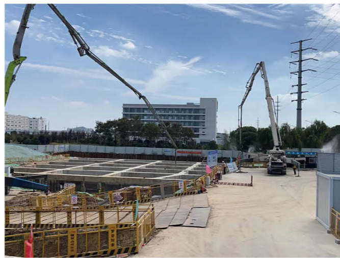
浒墅关经开区南部大包围圩区建设工程一标段
