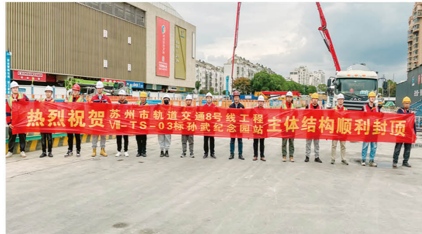
苏州轨交8号线孙武纪念馆站车站主体结构顺利封顶
