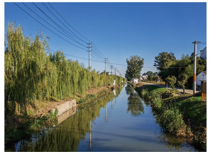
靖江市西片区水系联通工程新桥片区二期项目
