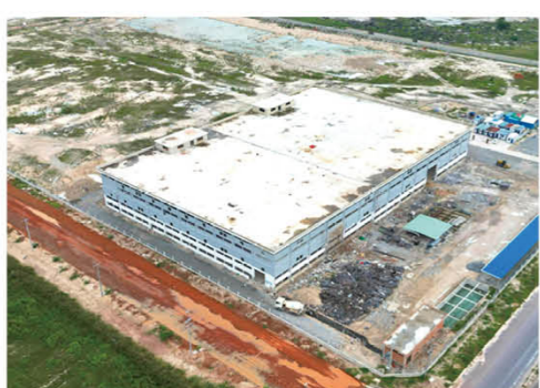
越南凯迪国际新建厂房项目
