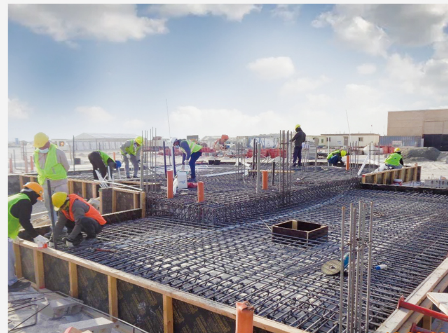
巴林东锡特拉保障房项目在进行1标段筏板钢筋安装工作
