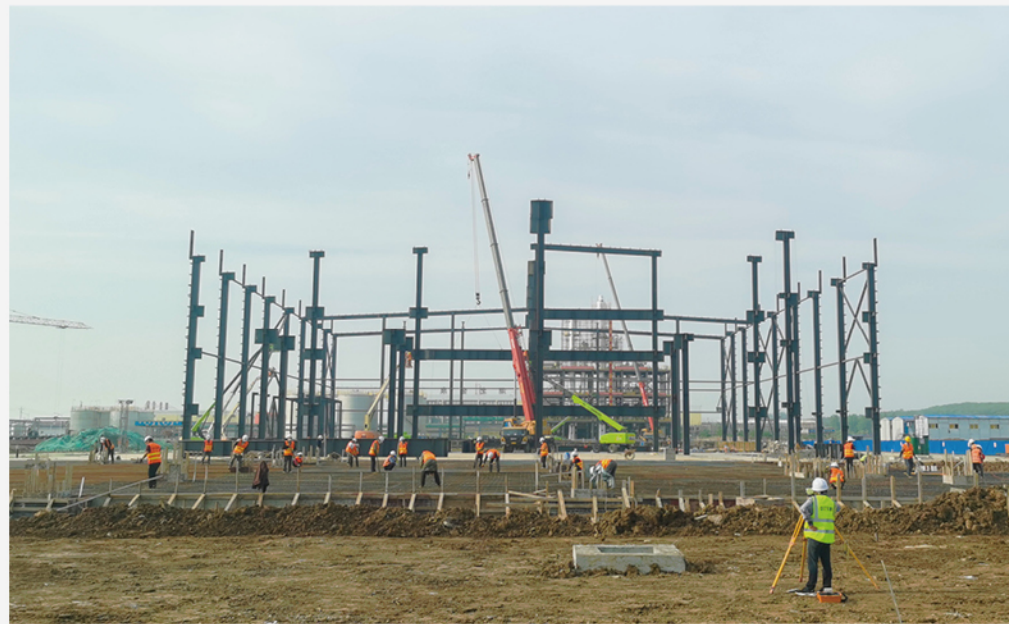
金泉拉练项目现场
